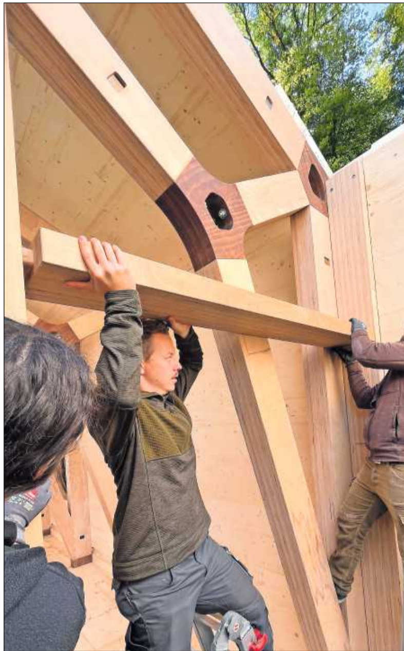
Holz-Lego-Prinzip: Bauen mit vorgefertigten Elementen funktioniert anders als die altbekannten Methoden.
