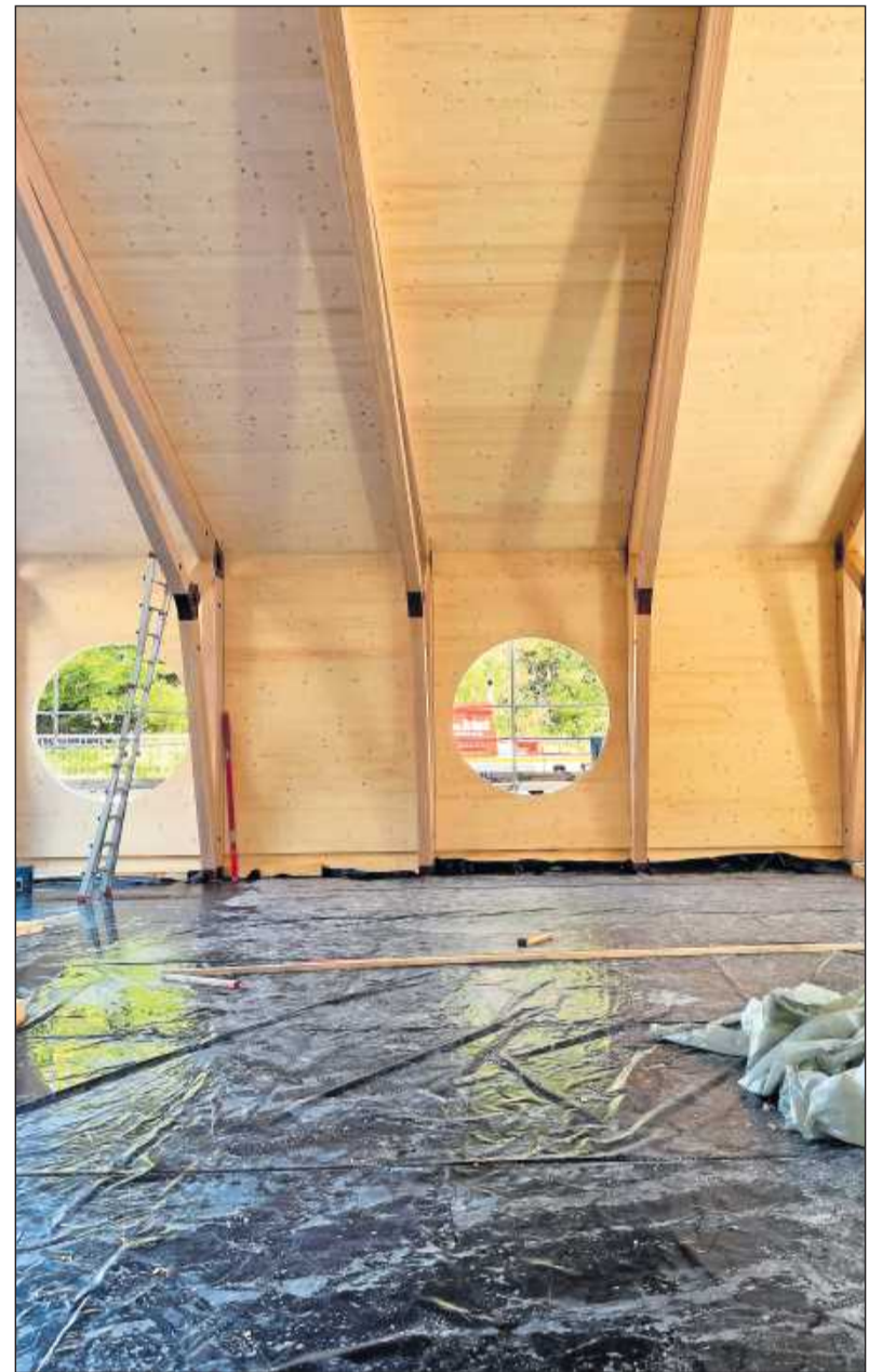
Nichts verleimt: Die Halle der TU Kaiserslautern im Diemersteiner Tal lange vor dem Richtfest im November. Bald beginnt der Innenausbau.
